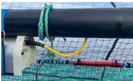
Figur 7. Korrekt bue på kabel.
