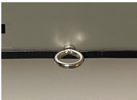
Figur 5. Ferdig montert øyebolt
