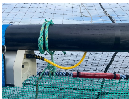
Figur 6. Korrekt bue på kabel.
