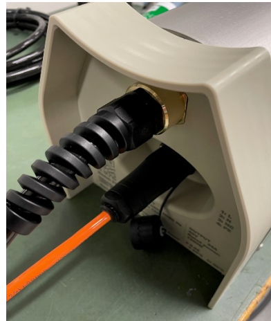
Figur 10. Strømkabel korrekt koblet til PDC
